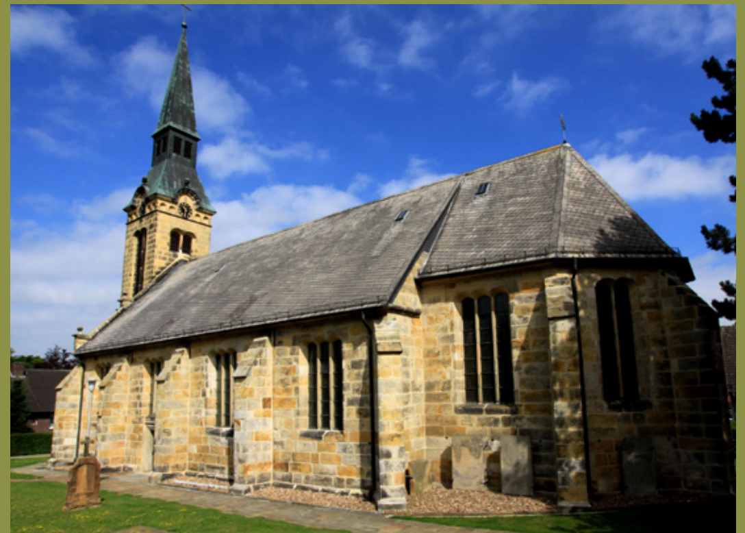
33 Katholieke kerk in Bad Bentheim, gebouwd in 1670 in opdracht van graaf Ernst Wilhelm. De toren is later bijgebouwd
